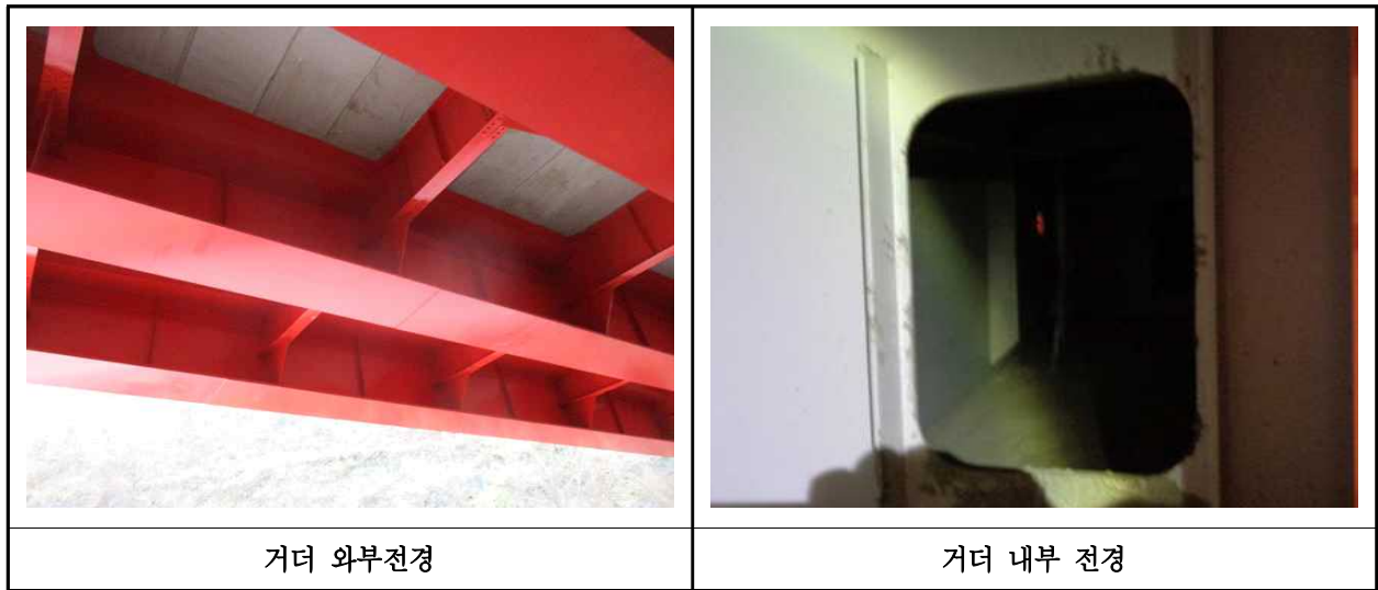
【사진 6.3.4】 거더 전경
