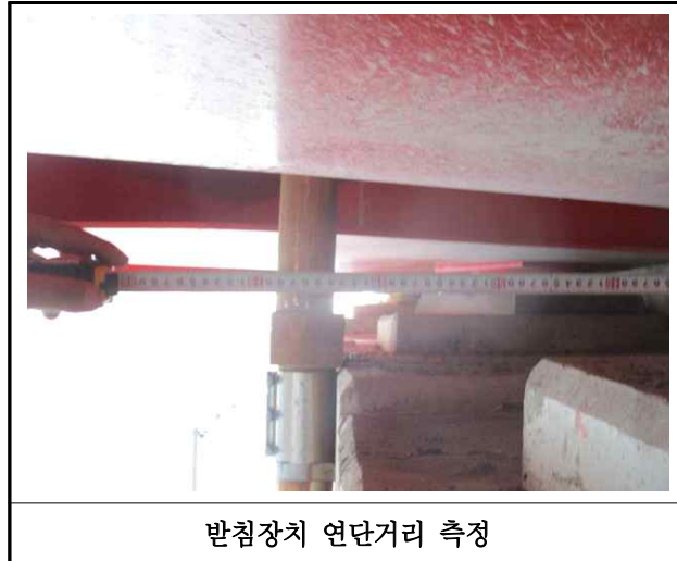
【사진 6.3.14】 교량받침장치 연단거리측정
