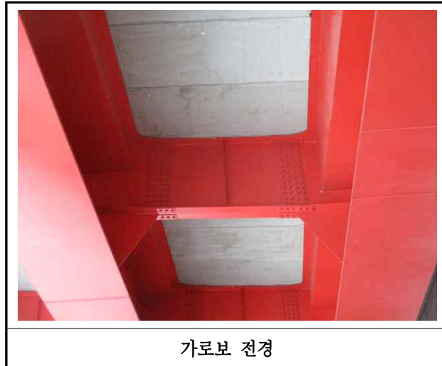
【사진 6.3.6】 가로보 전경
