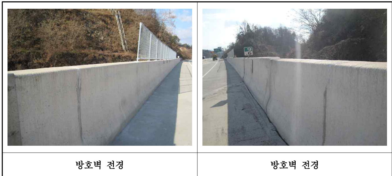
【사진 6.3.23】 방호벽 및 중앙분리대 전경
