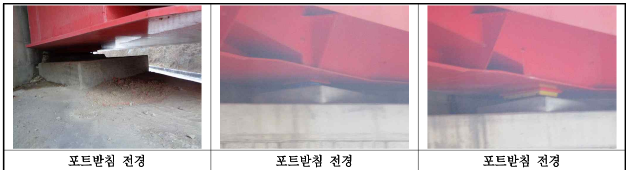
【사진 6.3.12】 교량받침 전경
