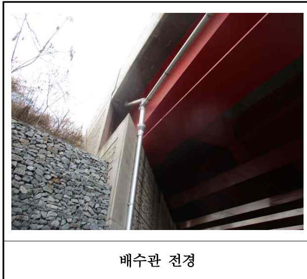
【사진 6.3.21】 배수시설 전경
