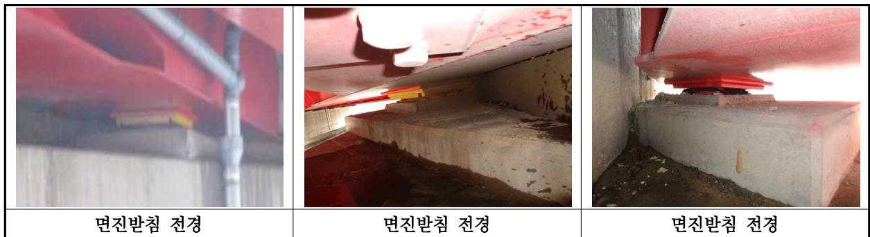
【사진 6.3.12】 교량받침 전경
