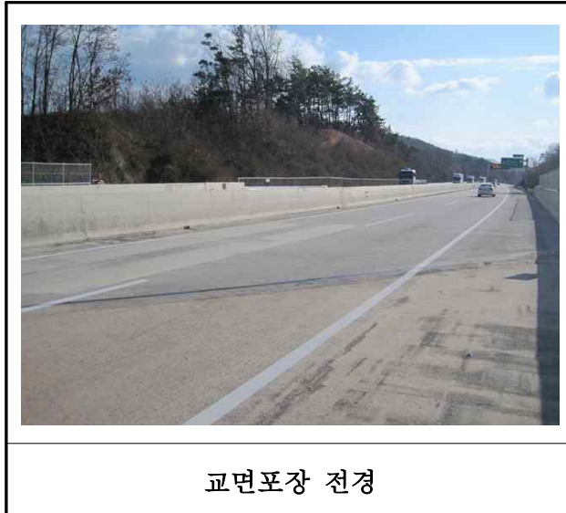
【사진 6.3.19】 교면포장 전경
