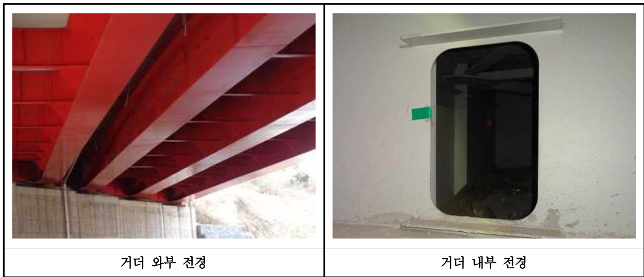
【사진 6.3.4】 거더 전경
