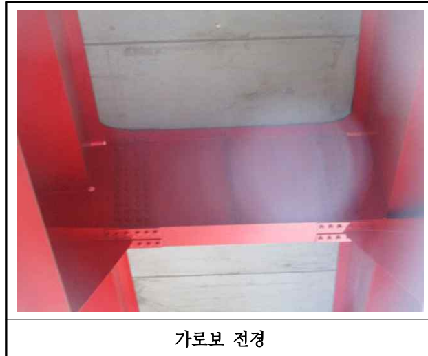
【사진 6.3.6】 가로보 전경
