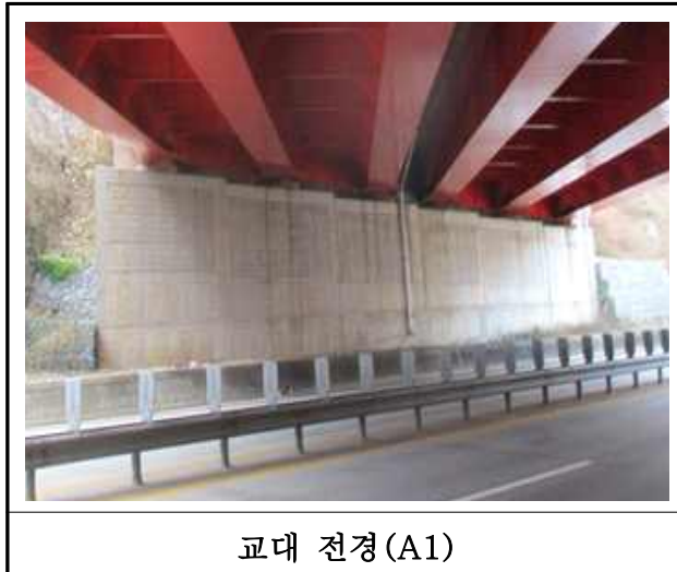
【사진 6.3.8】 교대 전경
