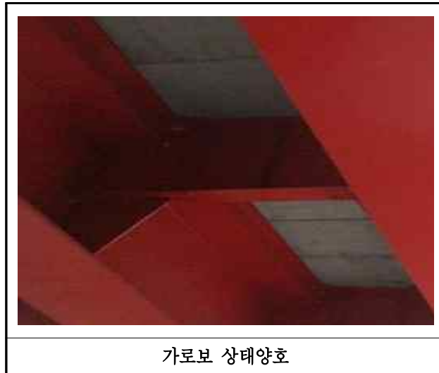
【사진 6.3.7】 가로보 손상현황
