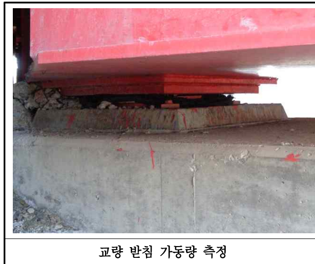
【사진 6.3.15】 교량받침 이동량 측정
