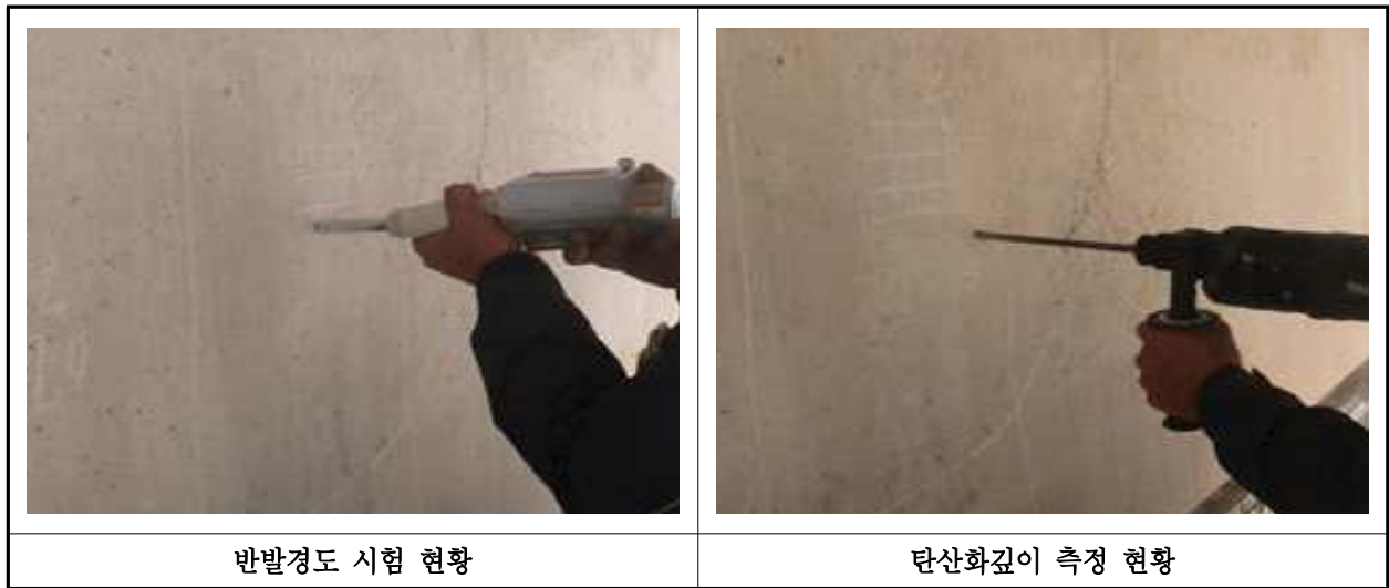
【사진 6.4.1】 콘크리트 내구성조사 현황
